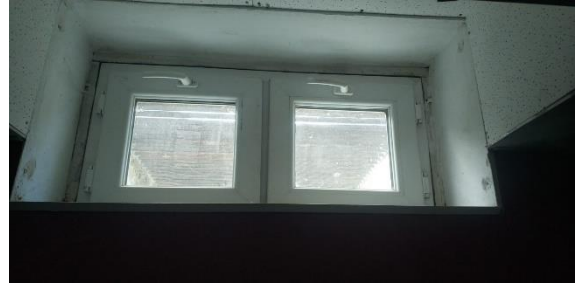
Resim 12: Konferans Salonu Havalandırma Çalışmaları
